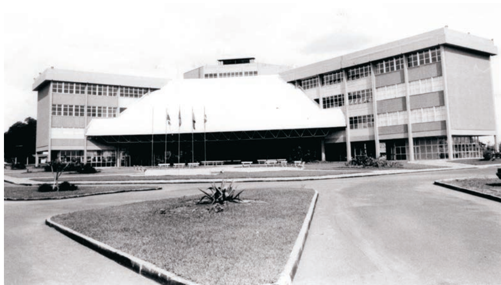
Módulo 1, década de 1980 - Imagem do início da construção e após a sua conclusão.
