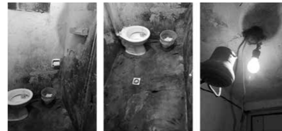
Figura 01 - Banheiro antes da reforma Fonte: Acervo Arquitetas Nômades, 2017.
