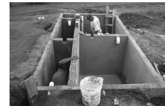
Imagem de etapa de execução do reator de tratamento de águas servidas. ONG PACTO/POA. Foto: Júlio Cruz.
