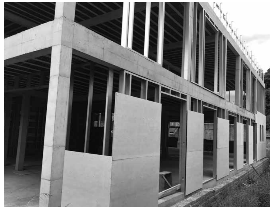
Figura 6 – fechamento da estrutura com aço galvanizado e placa cimentícia – Obra em Novo Hamburgo/RS
