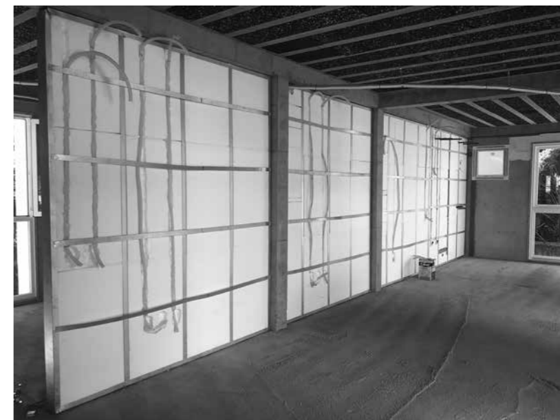
Figura 7(Acima) - Módulo de parede em aço galvanizado e núcleo em EPS. Fonte: Acervo Pessoal.
