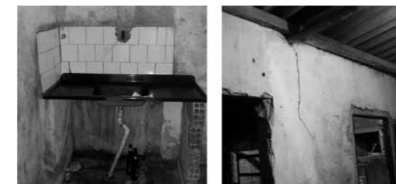
Figura 04 - Cozinha antes da reforma. Fonte: Acervo Arquitetas Nômades, 2018.
