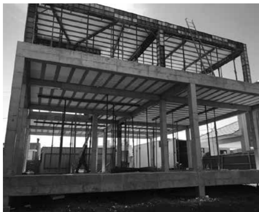
Figura 2 – Estrutura com forma metálica na cidade de Xangri-la/RS. Fonte: Acervo Pessoal
