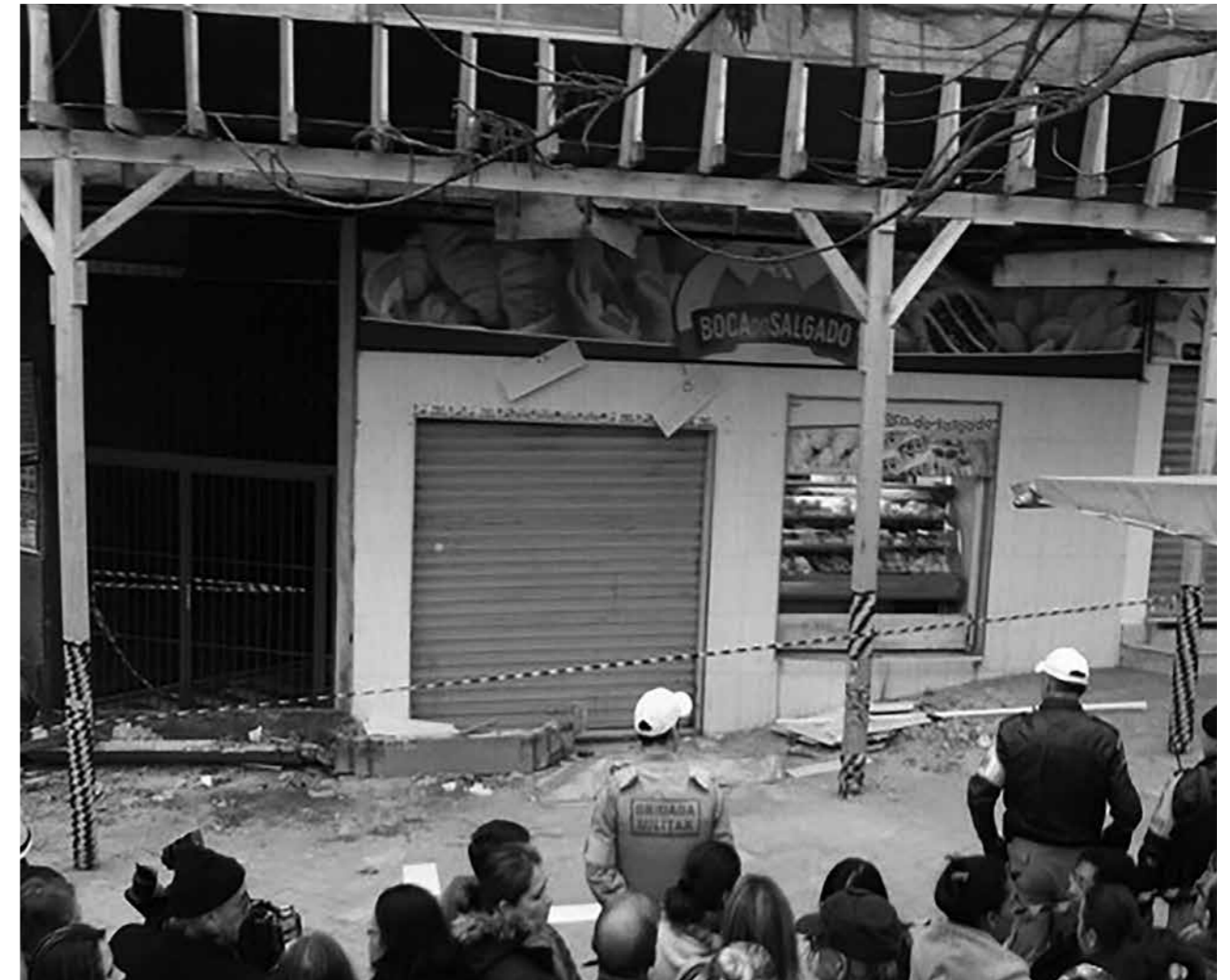
Figura 4: Desabamento de marquise durante obra em fachada no centro de Porto Alegre em 2016.
