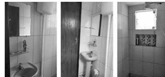
Figura 02 - Banheiro após a reforma Fonte: Acervo Arquitetas Nômades, 2017.
