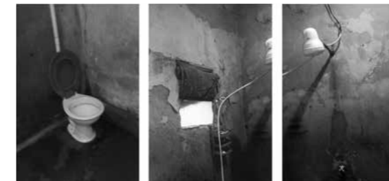
Figura 03 - Banheiro antes da reforma. Fonte: Acervo Arquitetas Nômades, 2018.
