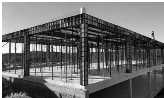
Figura 3 – Formas metálicas em Estância Velha-RS. Fonte: Acervo Pessoal
