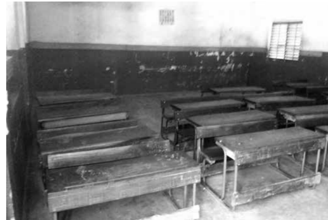
Sala de aula da Escola Lycée Lumière. Fonte: Autor, (2017).
