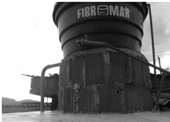
Figura 07 - Reforma no apoio da caixa d'água. Fonte: Acervo Arquitetas Nômades, 2018.
