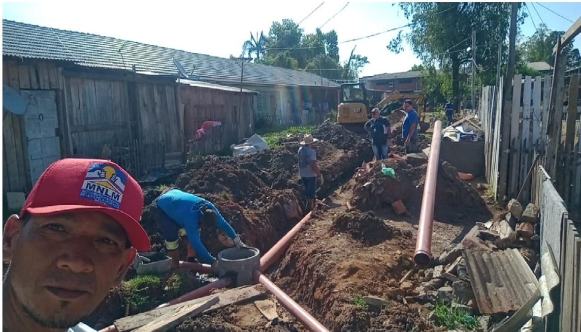
**Figura 05 -Instalação de rede de água e esgoto na comunidade pela equipe do SEMAE.
