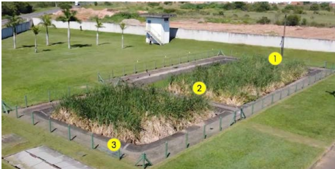
Figura 39 - Pontos de coleta para monitoramento da ETE BoxFlex
