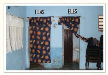
Pintura deteriorada ocasionada por infiltração na entrada dos banheiros
