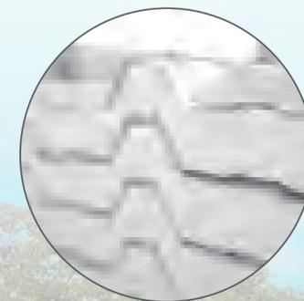
Telha sanduíche: utilizado no fechamento lateral e cobertura, garantindo o conforto térmico nas unidades.
