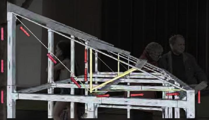
A estrutura da cobertura possui o sistema de "vigas vagão", assim contribui para que o peso superior da cobertura seja direcionado para as estruturas de sustentação principais.
