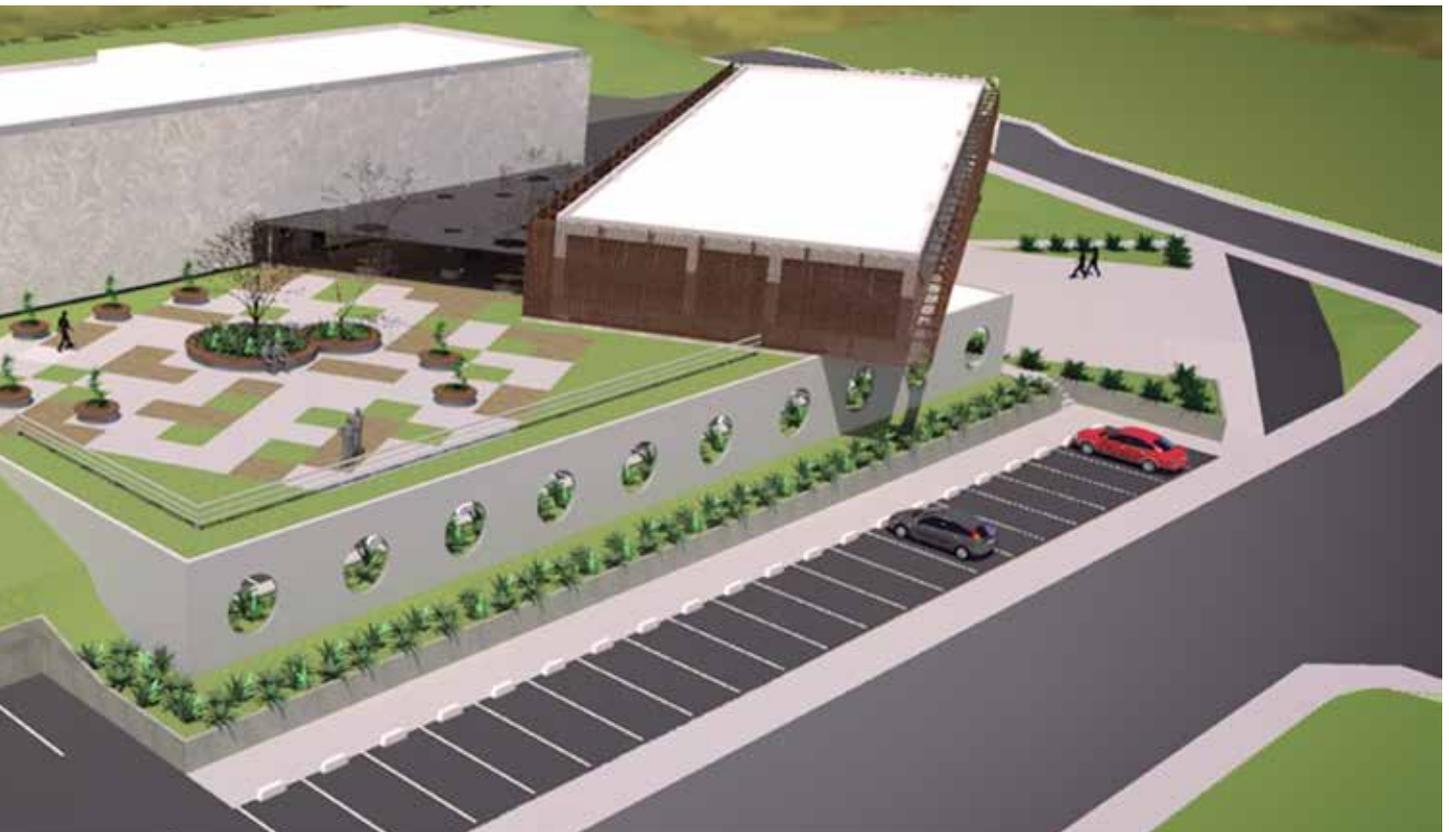
Quanto à flexibilização da planta: o volume posterior que contempla em grande parte salas de aula e laboratórios possui uma estrutura regradada. Trabalhando somente com o ângulo de 90°, faz com que os ambientes se adaptem facilmente a uma possível mudança de uso com pequenas alterações internas de layout, sem a necessidade de grandes intervenções físicas na edificação.
