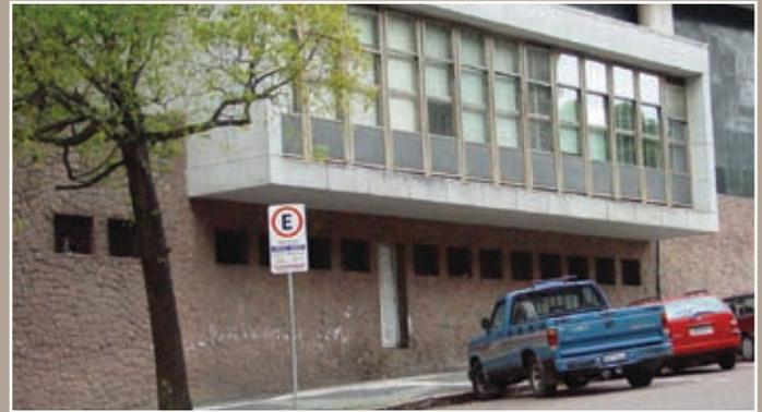
Antes: o revestimento existente de pastilhas com a estereotomia marcada também por pastilhas, porém de cor cinza escuro, e as esquadrias antigas.
