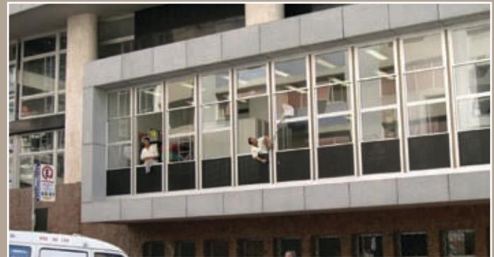
Depois: o revestimento de granito com a estereotomia marcada por juntas com selante à base de poliuretano, e as esquadrias novas de alumínio.
