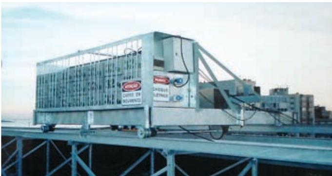
O sistema de contrapeso do andaime elétrico, fixado na cobertura, que corria paralelamente à platibanda.
