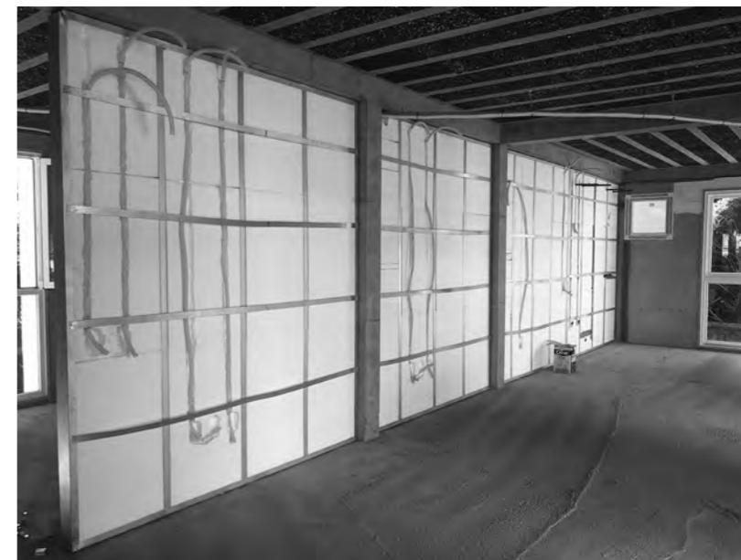
Figura 8(Direita) - Módulos de parede fixados nas posições finais.
