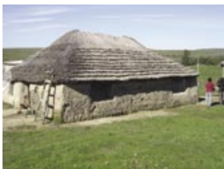
Extração de leivas e casa de taipa de torrões no interior de Aceguá, fronteira com Uruguai, 2007.
