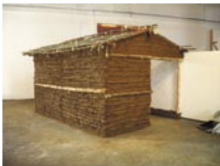
Casa tradicional guarani de pau-a-pique, construída na 5ª Bienal de Artes Visuais do Mercosul.
