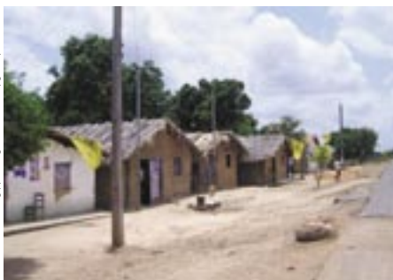
Humildes casas de taipa, cobertas com palhas da palmeira de babaçu, no interior do estado do Maranhão.
