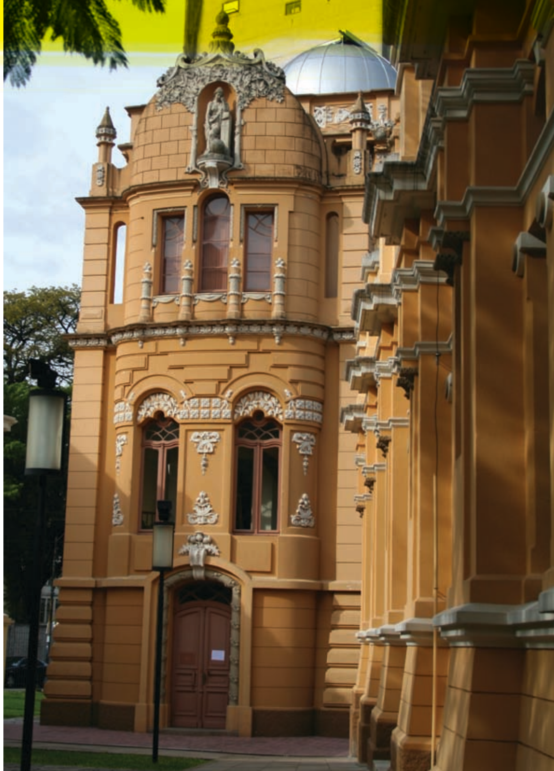
Figura 30 – Observatório. Fonte: Ricardo Calovi, 2006
