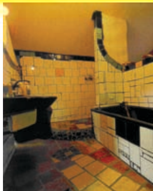
Vista interna de um banheiro, onde se observa a colocação irregular das peças cerâmicas (SCHMIED, 2005, p. 311).
