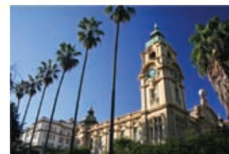
Figura 21- Correios e Telégrafos. Fonte: Ricardo Calovi, 2006
