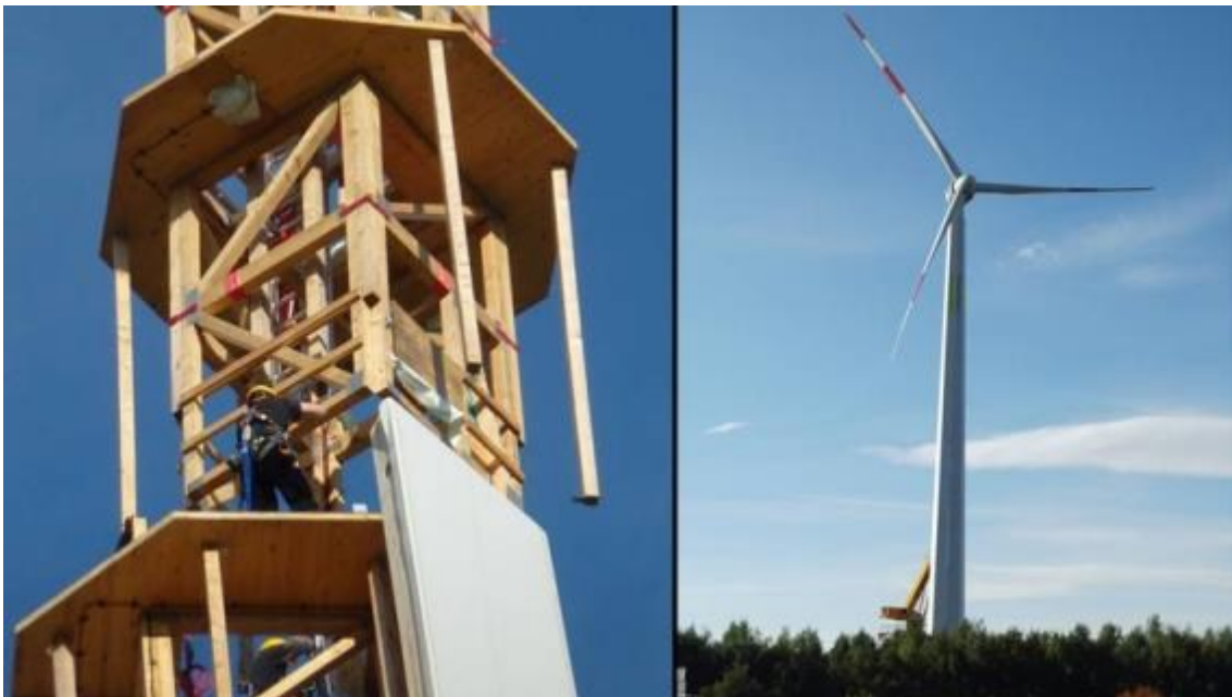
Figura 5 – Montagem e produto final da estrutura em madeira Timber Tower. Fonte: Timber Tower (2015).
