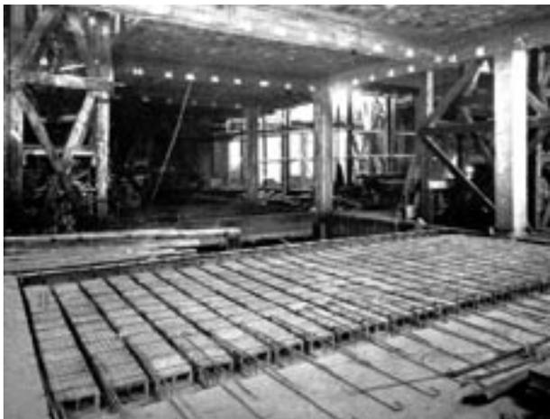
Fig. 02 - Gordon & Guton: The British-American Tobacco Co., LTD., Londres, 1913. Distribuição das peças cerâmicas e montagem das ferragens. (CONCRETE and Constructional Engineering, nov. 1913 Vol. VIII nº11): 750
