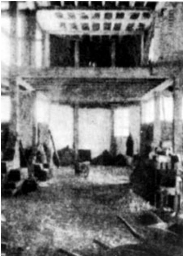
Fig. 12 - Le Corbusier: Villa Schwob, 1916. A imagem indica um sistema construtivo de laje plana semelhante ao utilizado no sistema Dom-ino. (FRAMPTON, 1979):64
