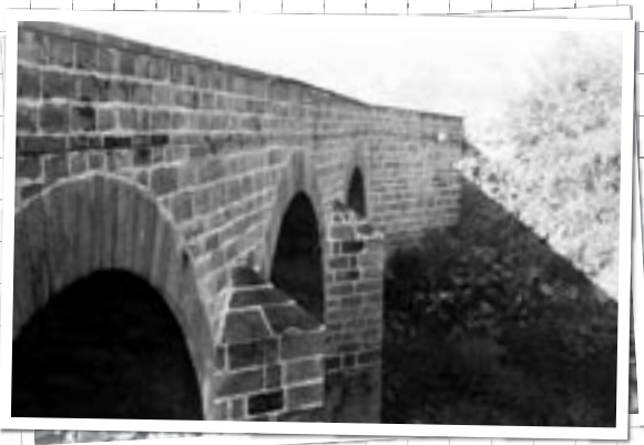
VISTA LATERAL DA PONTE DO IMPERADOR.
