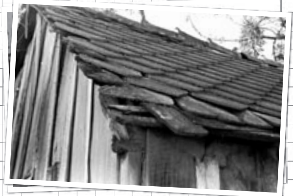
DETALHE DO TELHADO DE UMA ANTIGA MERCEARIA.
