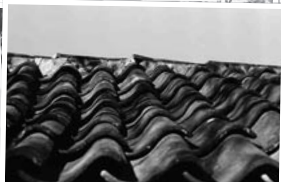
DETALHE DO ANTIGO TELHADO DE RESIDÊNCIAS HABITADAS POR IMIGRANTES EM IVOTI/RS.
