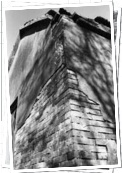
DETALHE DAS ESTRUTURAS DE UMA ANTIGA CONSTRUÇÃO ENXAIMEL.
