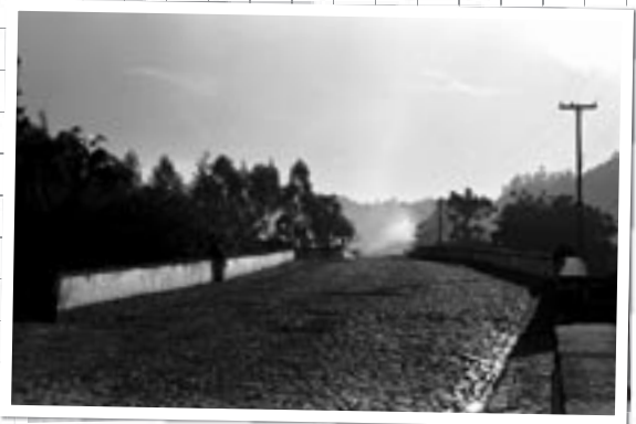
VISTA DE PARTE SUPERIOR DA PONTE DO IMPERADOR.
